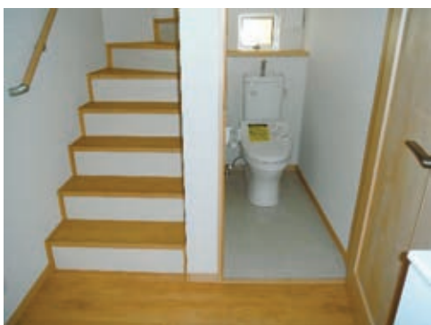
1階：階段・トイレ
